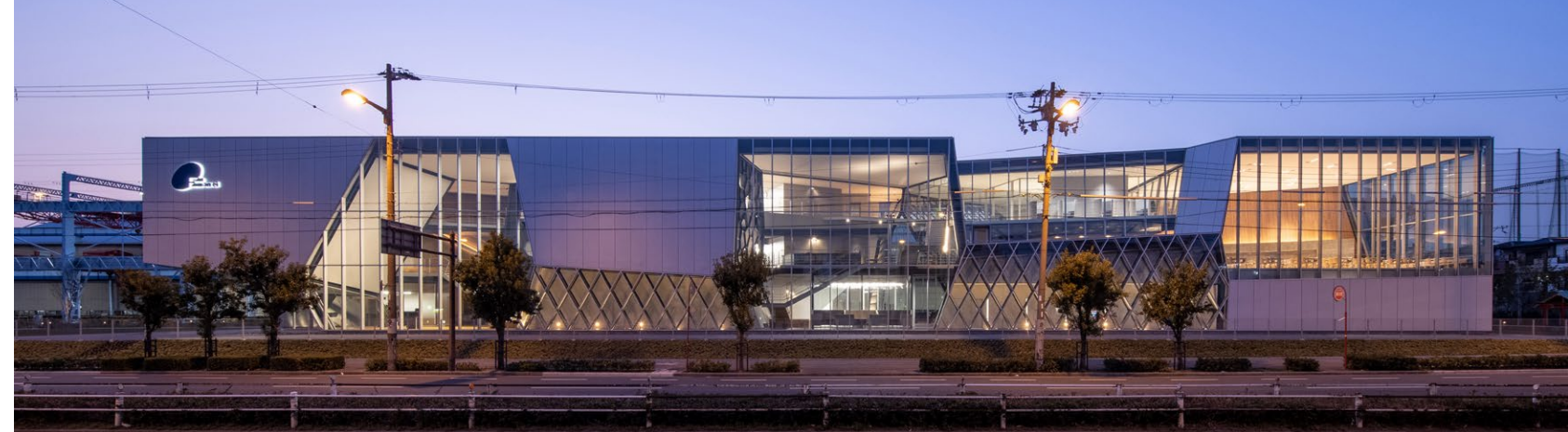
東側外観夕景。直方体のポリウムに対して、開口越しに立体ボロノイの奥行きが表出する。
